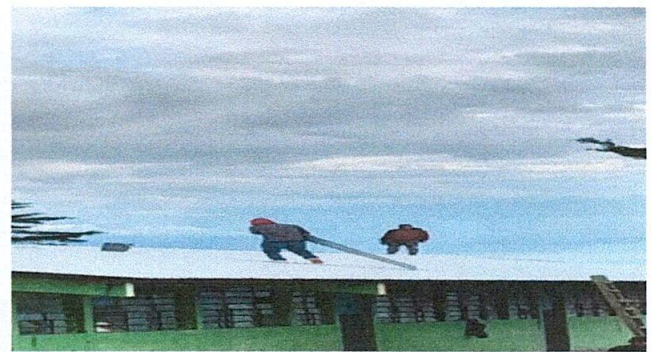
Foto 4: sustitución de lámina
