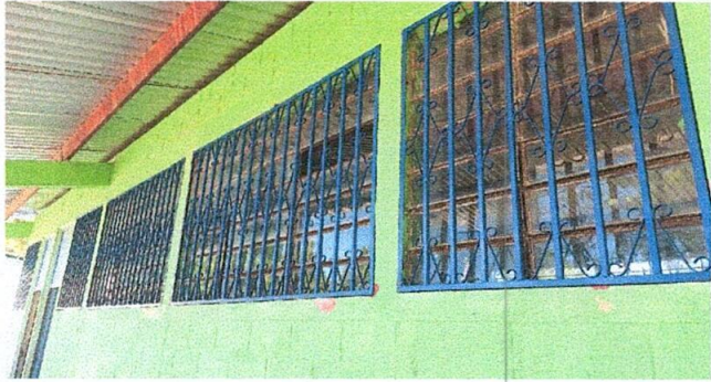
Foto1: Sustitución de balcones
