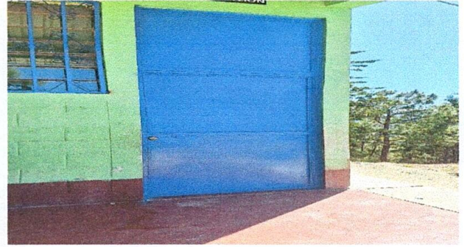
Foto 2: Mantenimiento de puerta
