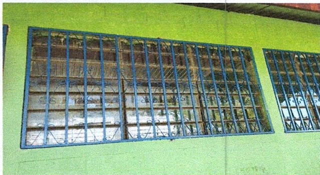
Foto 3: Sustitución de balcones
